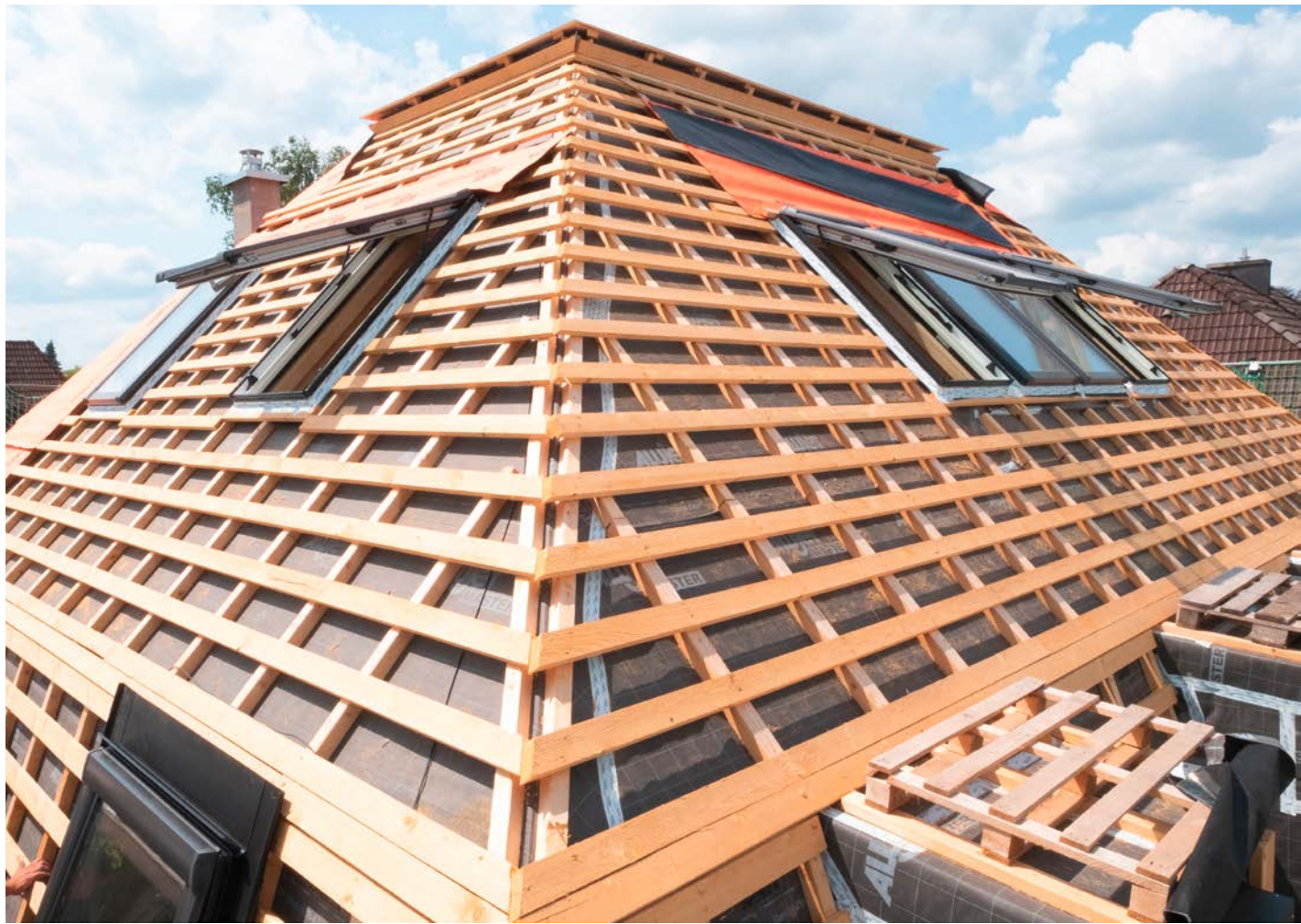
Die zur Montage der Solarpaneele erforderliche Dachlattung
