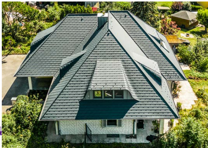
Das neue Aluminiumdach in Einbeck
